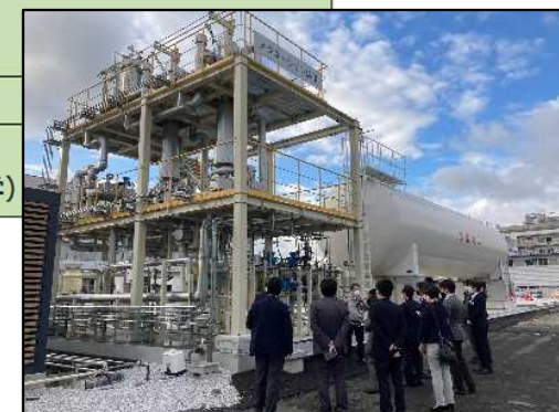
東京ガス(株) メタネーション設備などの見学 (2022年11月)
